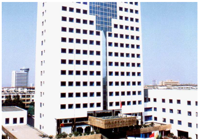
工程：中铁十四局集团有限公司西安行政中心项目部 地点：中国·西安 明细：宇天挂板及双玻百叶
